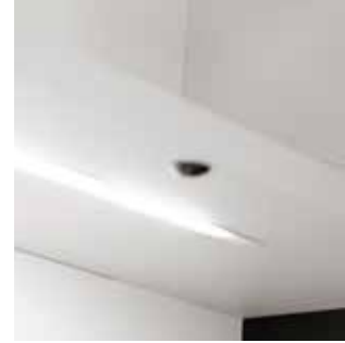
Energieeffiziente LED-Beleuchtung im Innenraum.
